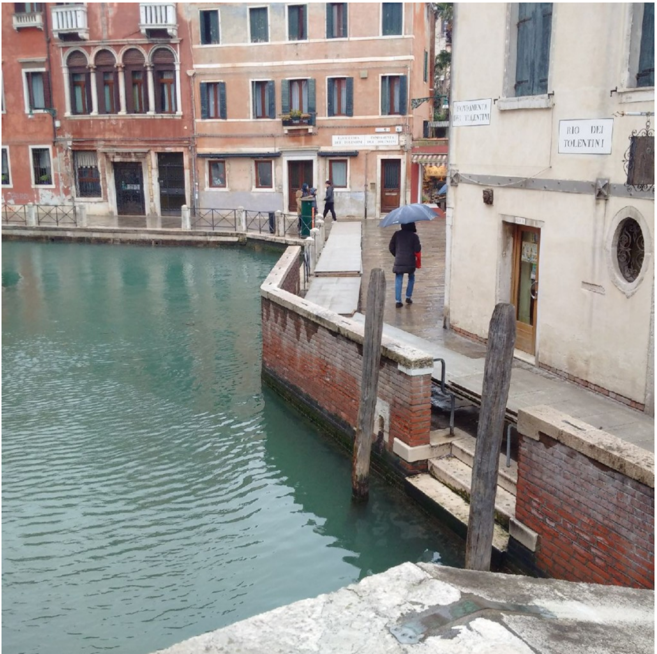
Passerelle pronte per l'acqua alta
